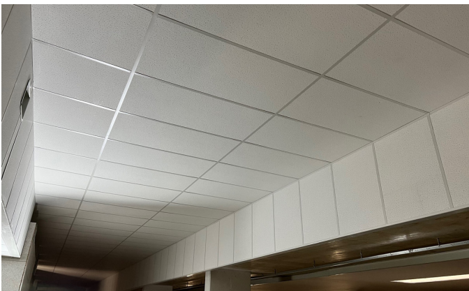
Decken- und Unterzugbereich
