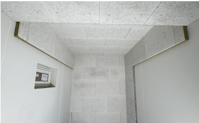
Flur und Nebenraum
