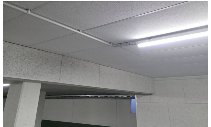
Übergang an Decke und Unterzug
