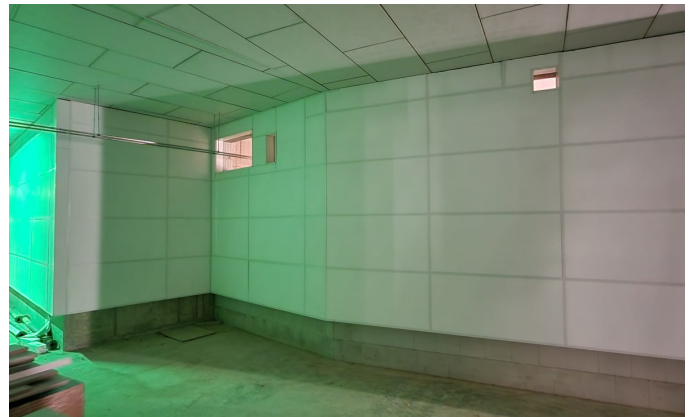
Wand- und Deckenbereich
