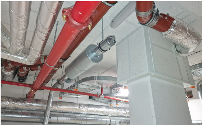
Stütze und Installationen
