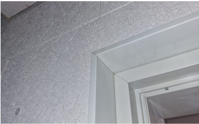
Türanschluss mit Kantenschutzprofil
