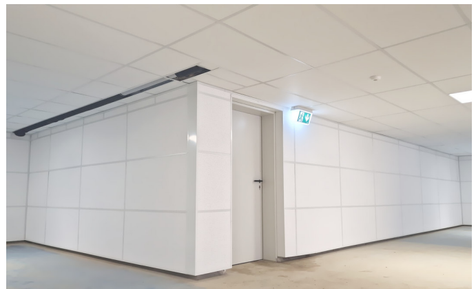
Decken- und Wanddämmung
