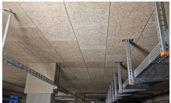
Dämmung bei Installationen
