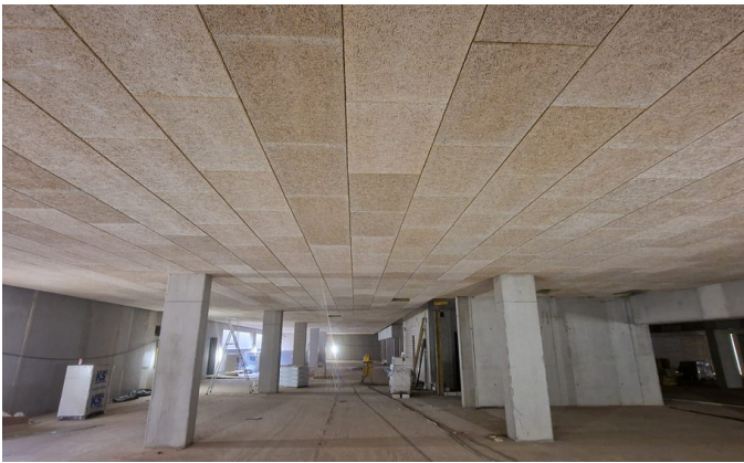
Deckenfläche im Bauzustand
